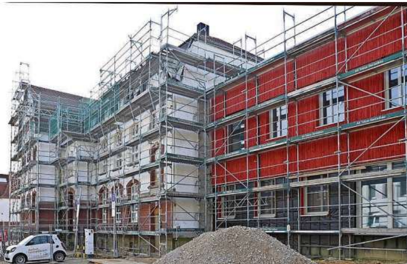
Das neue Gerüst am Schulgebäude in der Kaiserstraße steht, derzeit wird unter anderem die Fassade des Neubaus mit Holz verkleidet. FOTO: DAGMAR MEYER-ROEGER
